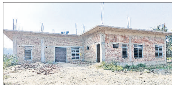
बहादुरगढ़। बादली रोड पर टाउन पार्क के निकट रुका पड़ा रैन बसेरे का निर्माण।
